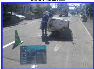
舗装切断工
